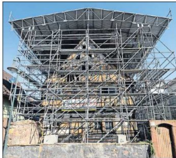
Eingerüstet und überdacht: das „Projekt 51“-Haus. FOTO: LM
